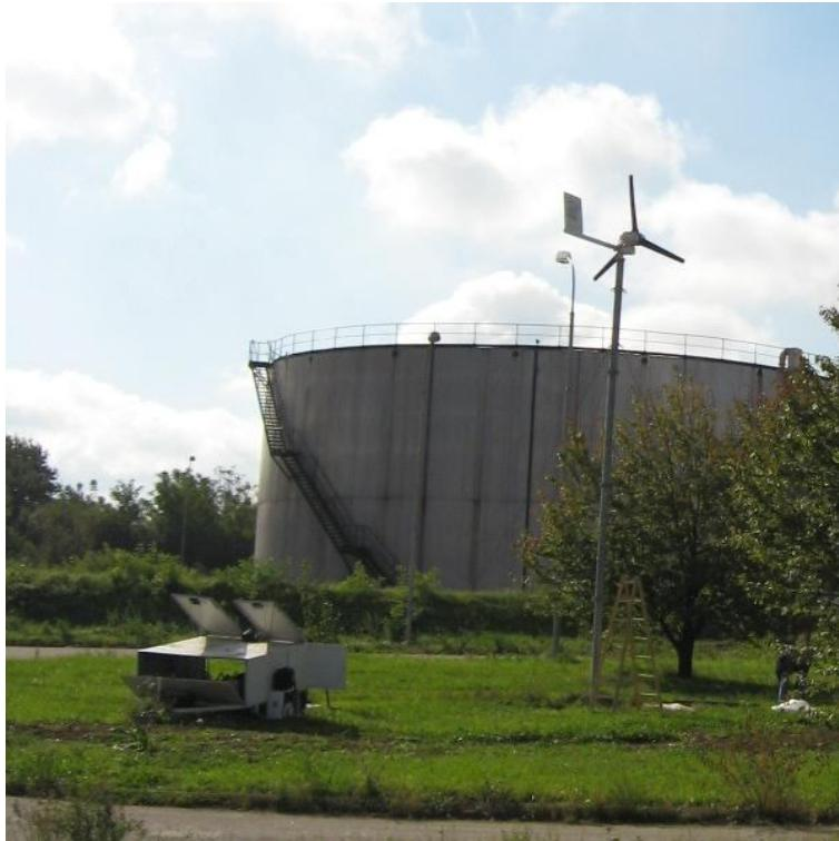
Slika 4 – Postavljeni hibridni vetar-solarni sistem na toplani Cerak
